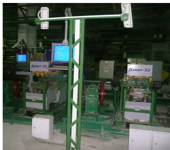
Две иммерсионные ванны в линии контроля с системой видеонаблюдения и выносными мониторами
